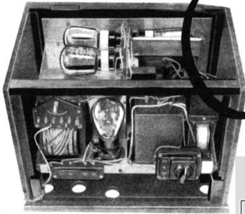
Die Schaltung der Niederfrequenzstufe.
